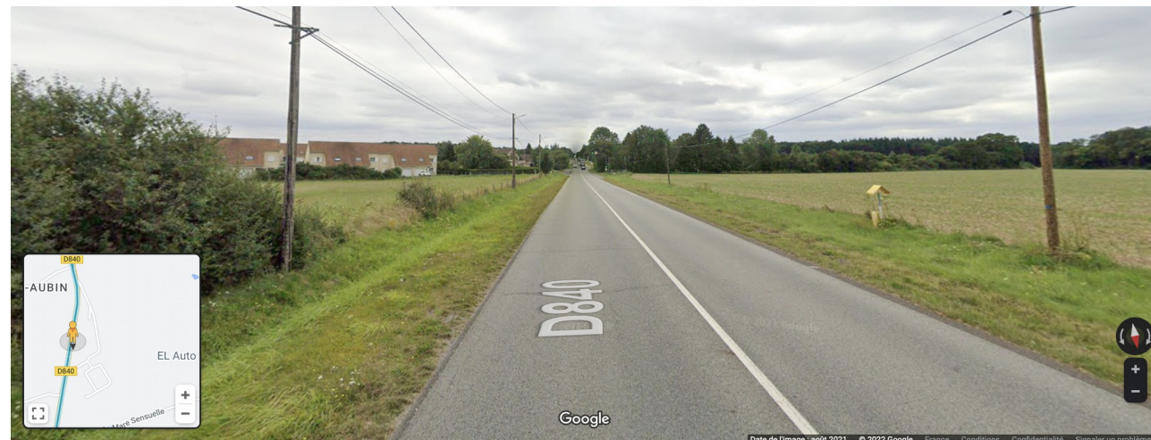
Illustration 52: Balise marquant la canalisation de gaz au niveau de la RD 840
