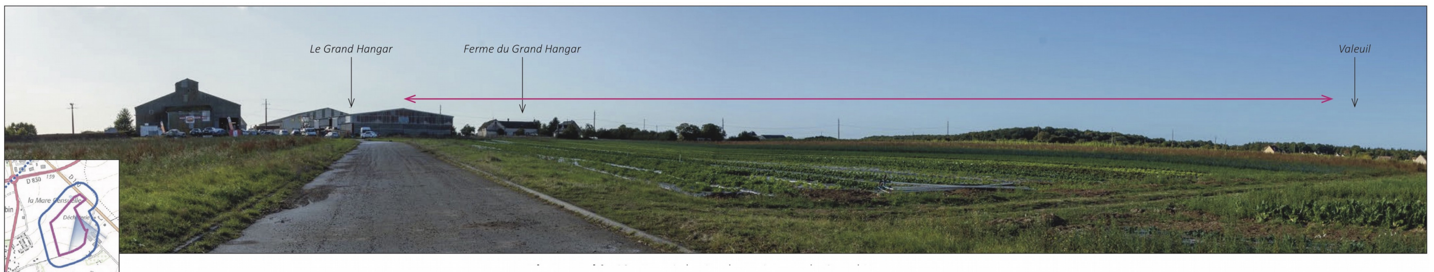
Photographie 13: Depuis le site du projet vers le Grand Hangar
